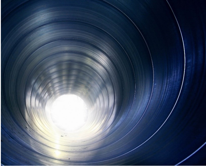
Kuva 4. Maatulivoimalan rungon sisäosa (Pemamek 2023, Pemamekin kuvapankki)
