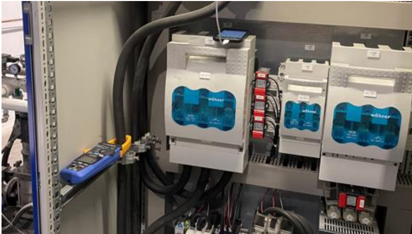
Kuva 26. Tyhjöuunin syöttövirran mittaus
