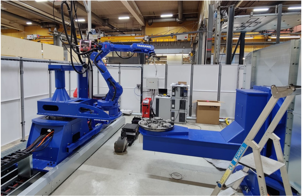
Kuva 12. Uusi Yaskawa3 robotti asennusvaiheessa.
