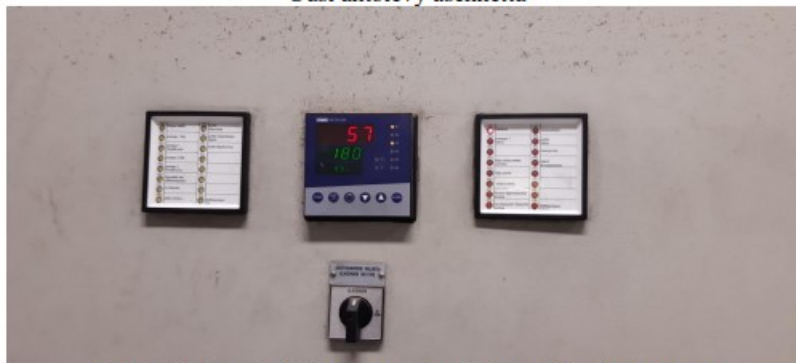
Uudet tilatieto- ja hälytyspaneelit vaihdettu ohjauskeskukseen
