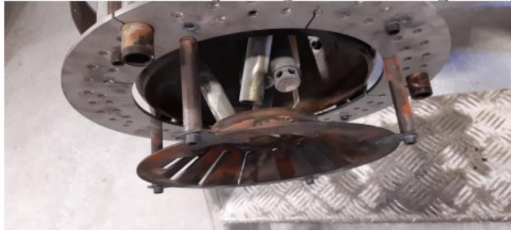
Uusi ahtolevy asennettu
