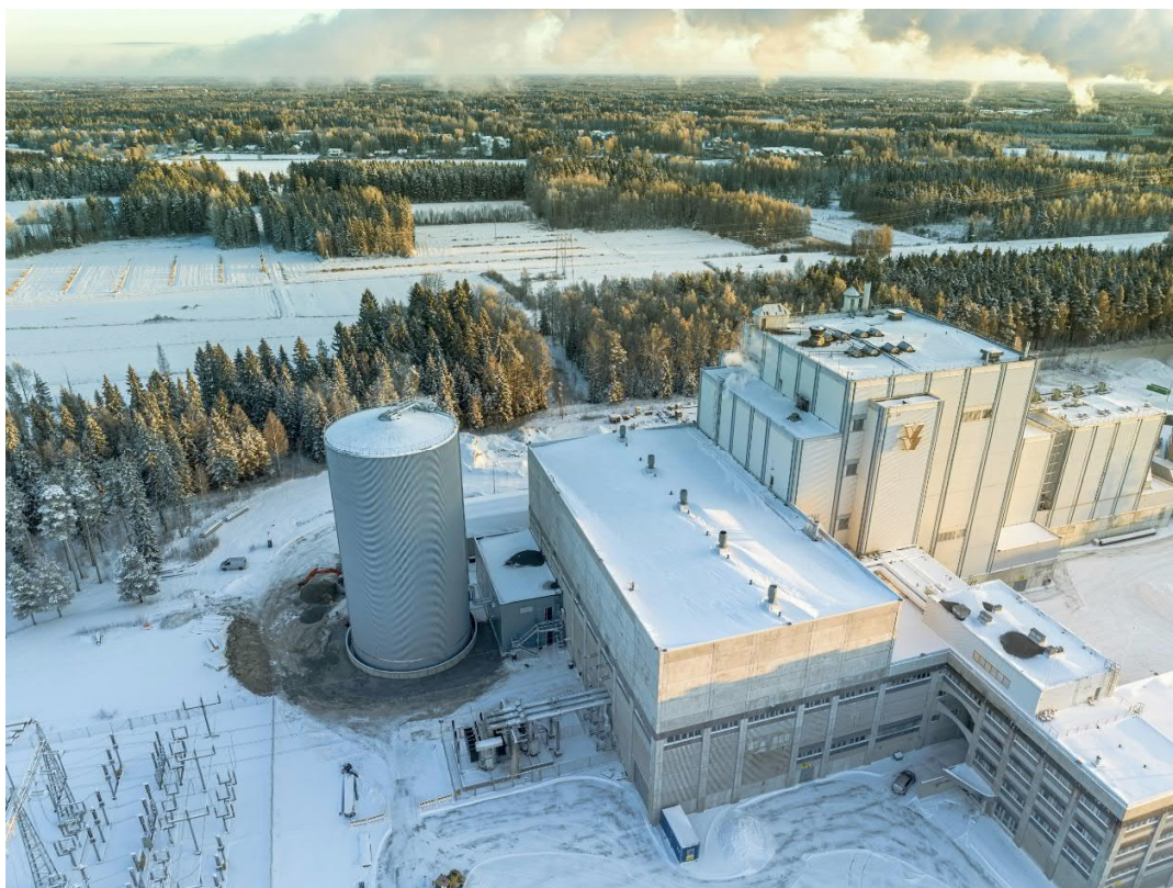
Kuva 9. 10 000 m 3 kaukolämpöakku Seinäjoen Voima Oy:n voimalaitoksen yhteydessä (Kuva: Seinäjoen Energia 2023)
