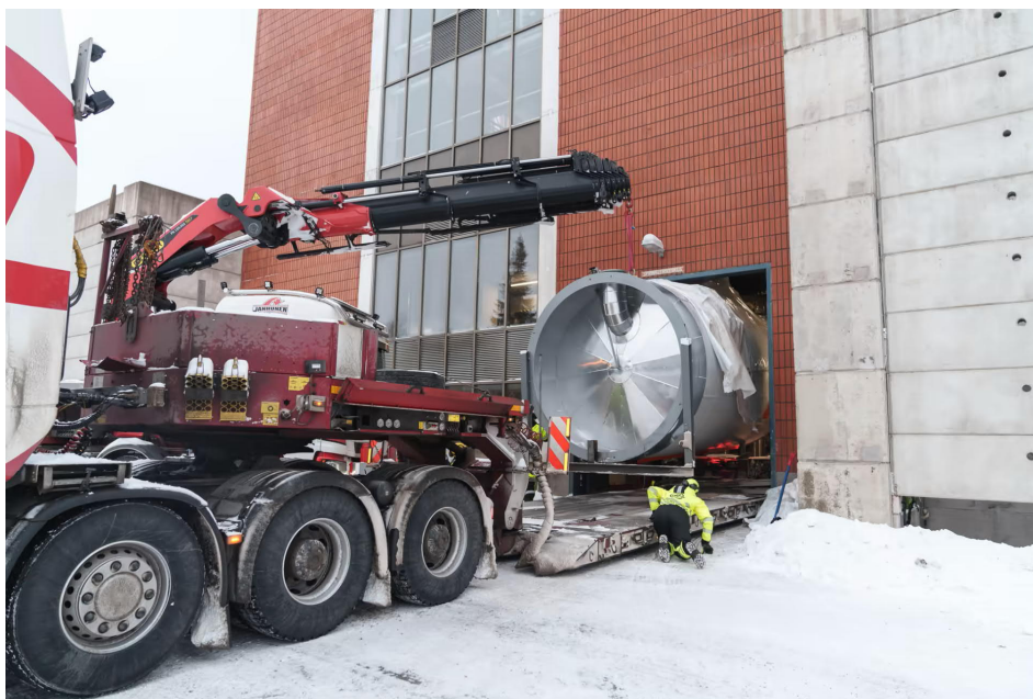
Kuva 11. Sähkökattilan asennusta Lielahdessa (Tampereen Sähkölaitos 2022).
