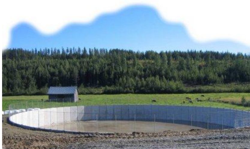
Kuva 10. Betonielementeistä koottu liotelantasäiliö. (Agrimarket 2007c)
