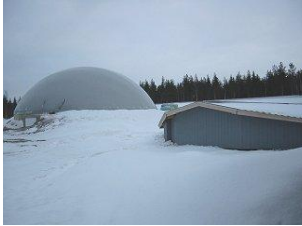
Kuva 21. Biokaasulaitoksen lieteallas ja kaasukupu. (Vaasan yliopisto 2007)
