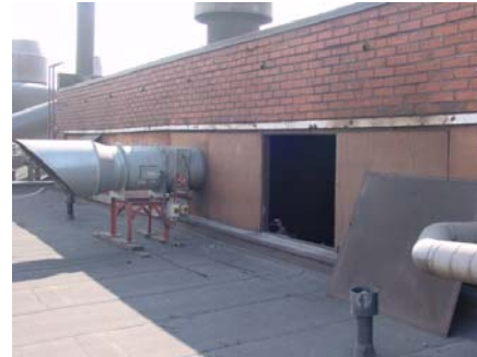
Kuva 50: Sulaton katon aukkoja
