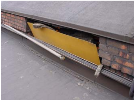
Kuva 49: Sulaton katon aukkoja
