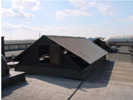
Kuva 46: Sulaton kattoluukkuja 1
