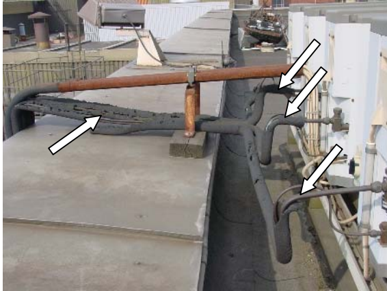
Kuva 43: Kylmäaineputkien eristeaurioita
