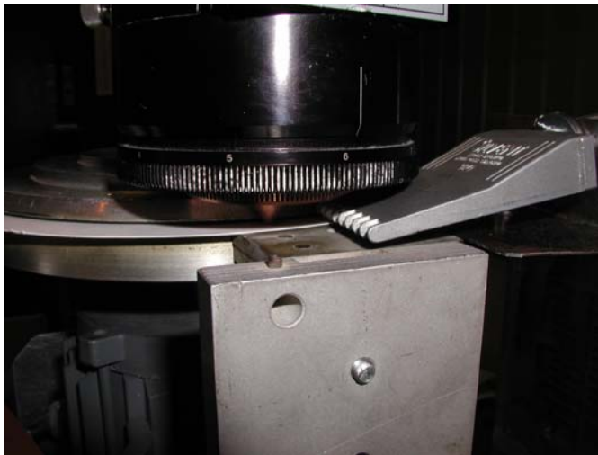
Kuva 89. Leikkauspään alle asennettu Silvent sivupuhallussuutin.
