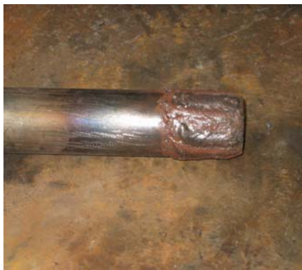
Kuva 56. Päällehitsattu akseli, jossa näkyy myös lämpövaikutusalueet
