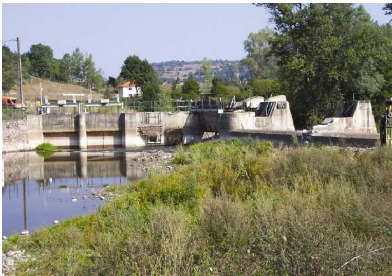
Loiressa sijainneen Brives Charensacin pato kesällä 2003 juuri ennen purkamista. Kuva: SOS Loire Vivante - ERN France / http://www.rivernet.org
