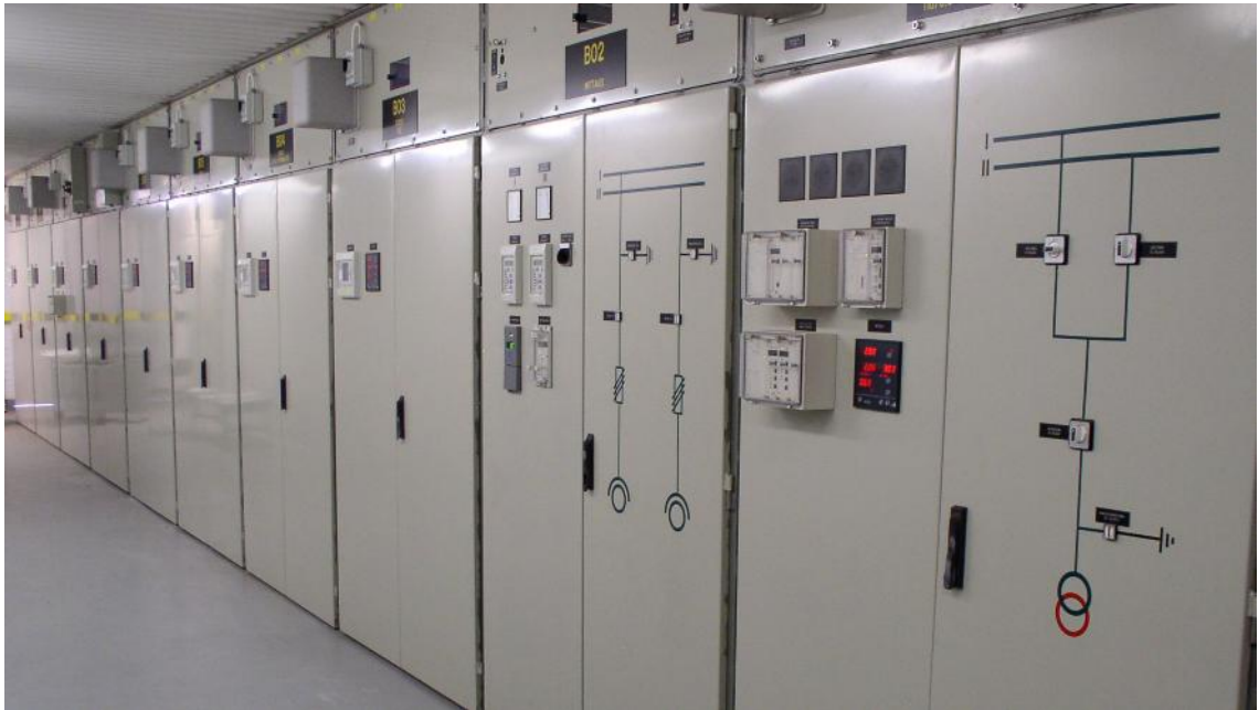
Kuva 2.3. 6,3 kV pääkeskus.
