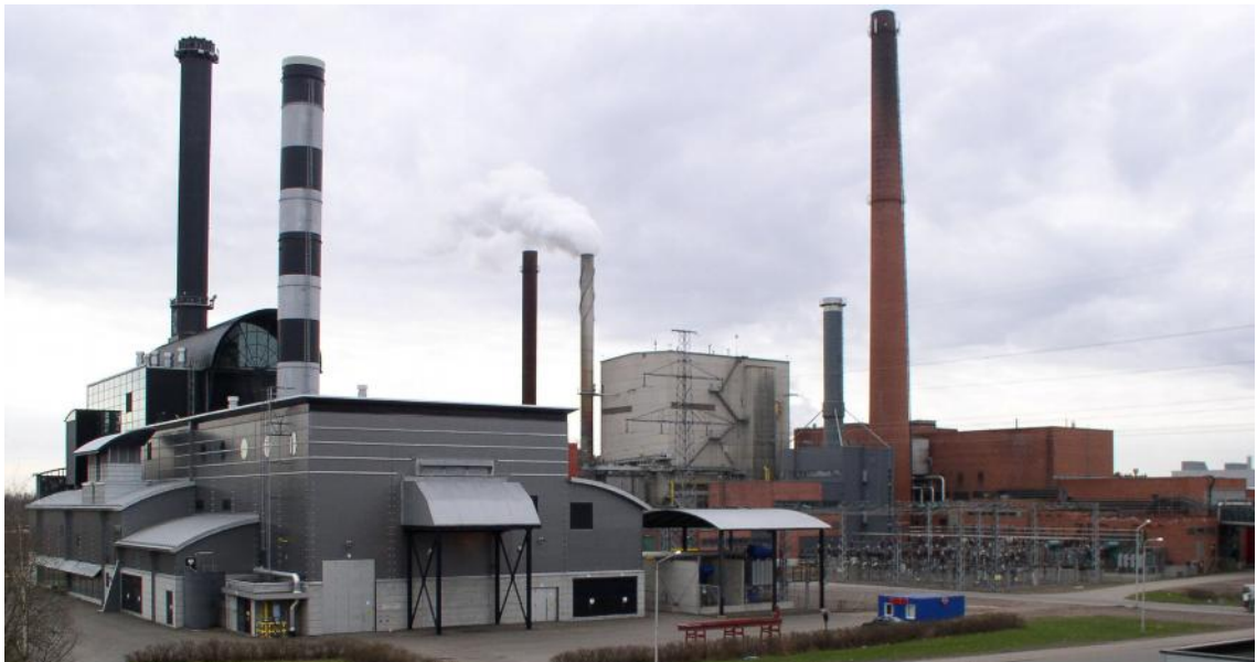
Kuva 1.5. Kombivoimalaitos (vas.) ja vastapaine- ja lauhdevoimalaitokset (oik.).
