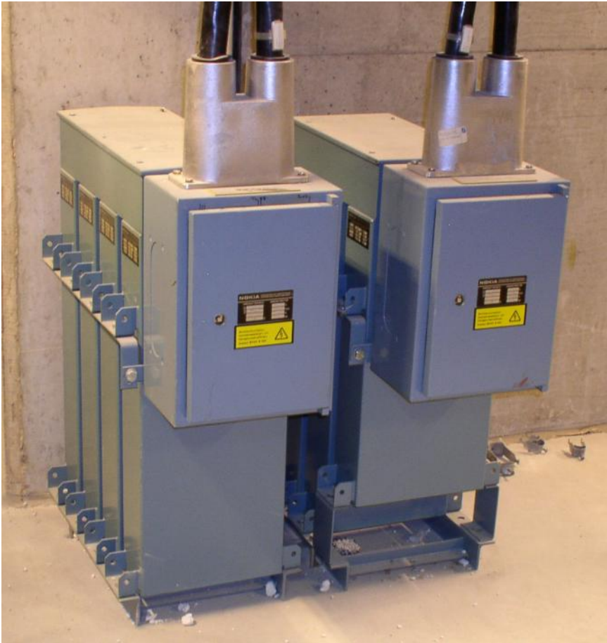
Kuva 3.6. Erään pienjännitekeskuksen kompensointiparistot.
