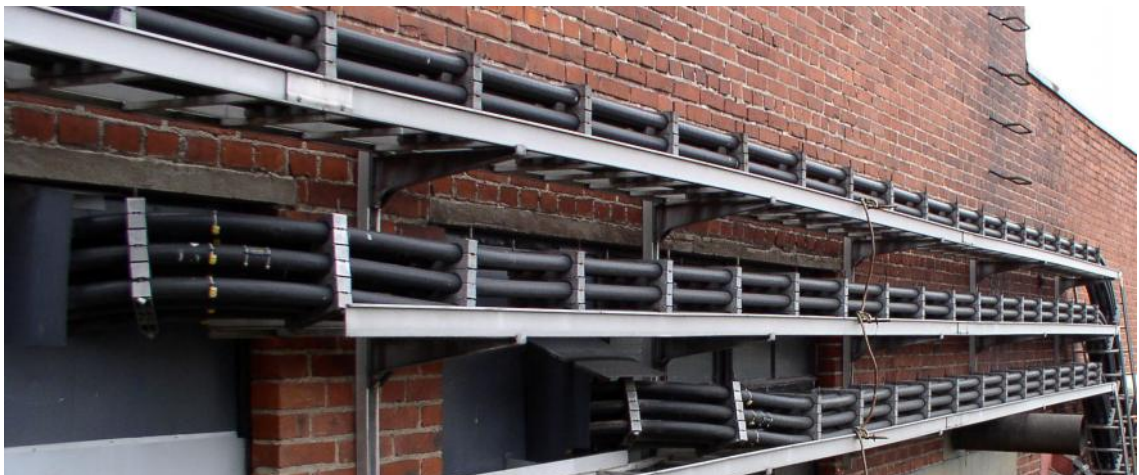
Kuva 2.5. Hiomoa syöttävät suurvirtajärjestelmät.
