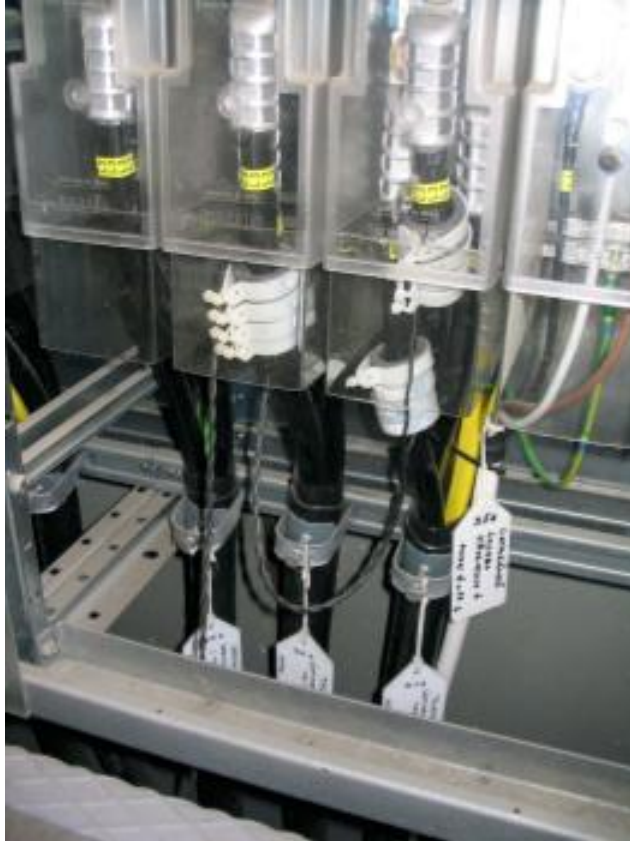
Kuva 4.2. PLC-modeemin induktiivinen kytkentä pienjänniteverkkoon jakelumuuntajalla (Ahola 06)
