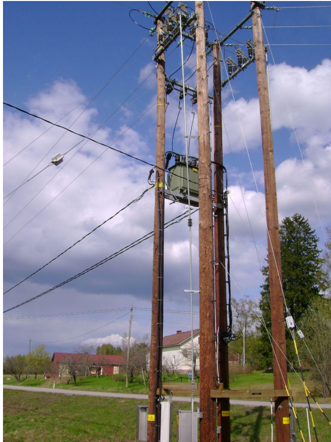
Kuva 8.1. Aistinvaraisen tarkastuksen kohteita ovat mm. johdinten asennuskorkeudet, harukset ja merkinnät.
