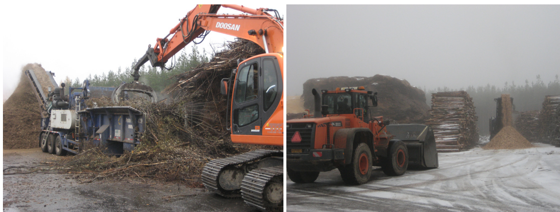
Kuvat 1 ja 2. Vasemmalla siirreltävä mobiilimurskain ja kaivinkone syöttämässä karsimattonta kokopuuta. Oikealla pyöräkuormaja rankamurskeen aumausta varten.
