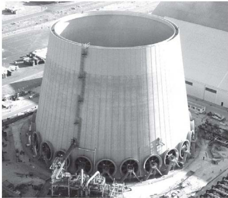
Kuva 12 Hyperbolinen jäähdytystorni, jossa ilmavirtausta tehostetaan merkittävästi kehälle asennetuilla puhaltimilla. (Hensley 2009)
