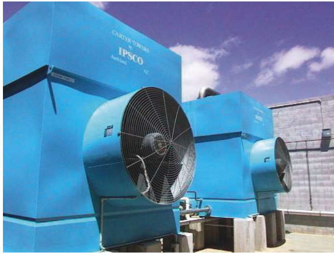
Kuva 15 Pystyvirtaustorni, johon puhallin on asennettu sivulle. © IPSCO Inc. 2003
