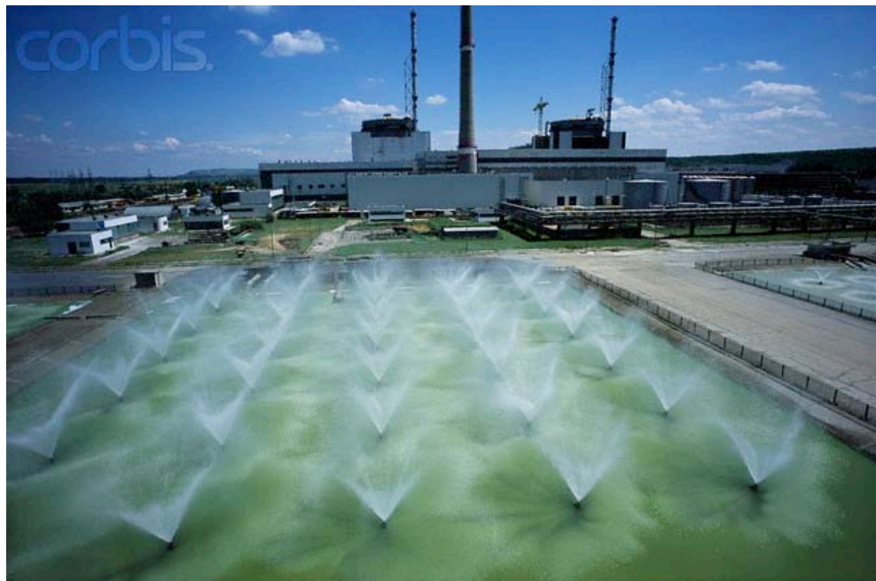
Kuva 7 Suihkutuslampijärjestelmä kemian tehtaan jäädytysyksikkönä. © Ed Kashi 2001/CORBIS
