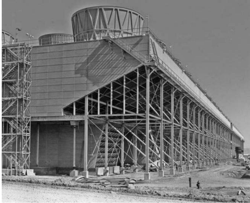
Kuva 18 Suuri hybriditorni kuuman kondenssiveden jäähdytyksessä. (Flynn 2007)
