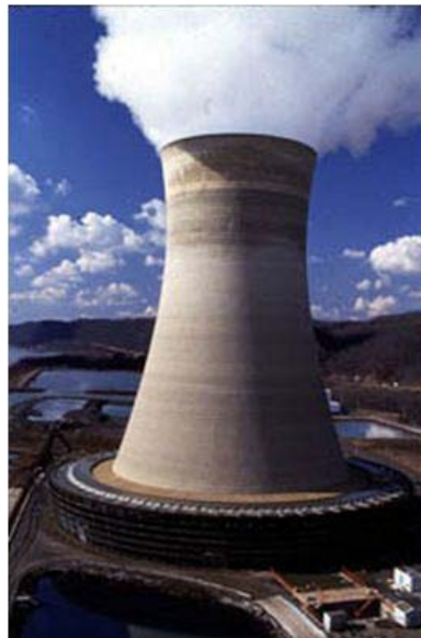
Kuva 11 Hyperbolinen jäähdytystorni, jonka lävitse ilma virtaa luonnollisesti perustuen kostean ja kuivan ilman tiheyseroon. (GE Water 2007)
