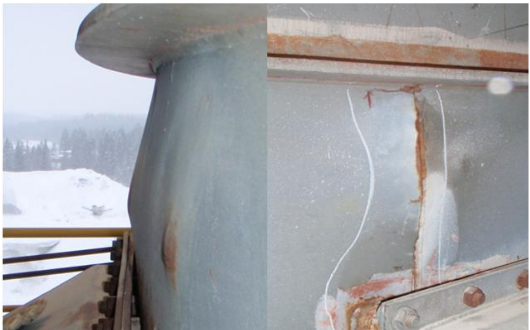
Kuva 6.10. Kuvassa näkyy tiilihyllyn kohdilla tapahtuneet muodonpuutokset ja murtumisen.
