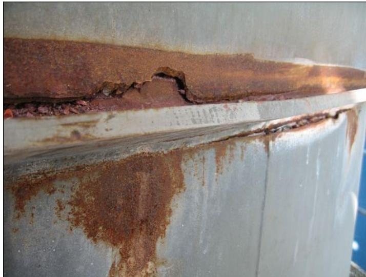
Kuva 5.11. Kalsinaattorin kuoreen syntynyt kehäsuuntainen murtuma.
