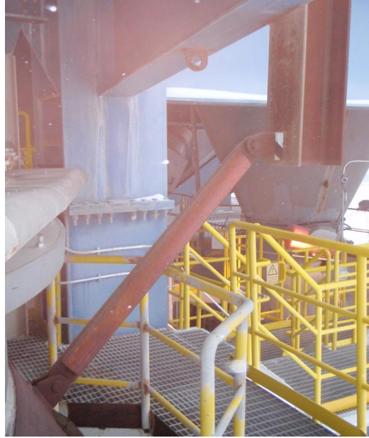
Kuva 6.3. Laskuputken ja joutsenkaulan tuentaan tehty vetosauva.
