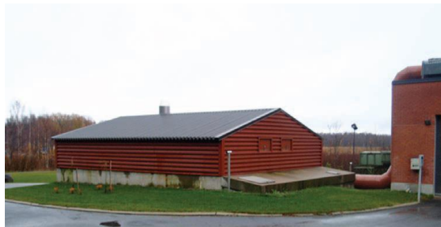
Kuva 44. Hajukaasujen siirtoputket ja biosuodatin (Latvala 2009, 105)
