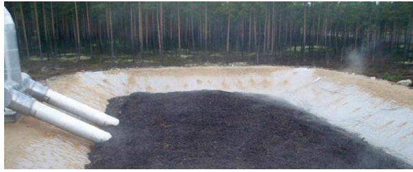
Kuva 21. Hajukaasujen siirtoputket ja biosuodatin (Latvala 2009, 101)
