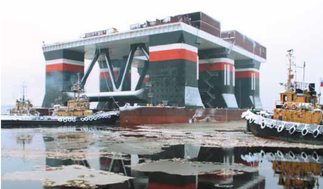
Kuva 34. Shtokmanin kaasukentälle valmistettavan porauslautan runko (Lukkari 2010b, s. 16)
