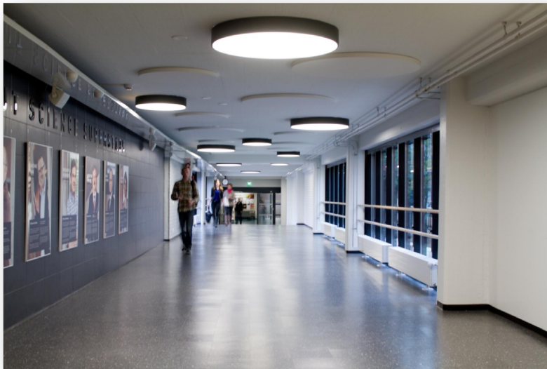
Kuva 34. Uusittu yhdyskäytävä. Pyöreät kattoabsorptiolevyt on lisätty mittausten jälkeen.
