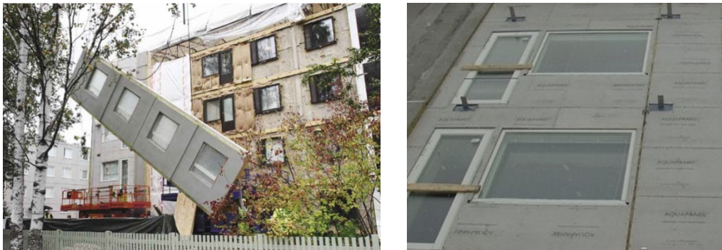
Рис. 3.1: Концепция «пассивного» дома фирмы «Paroc» основана на использовании готовых теплоизолированных фасадных панелей и энергоэффективных окон [Paroc, 2012b].
