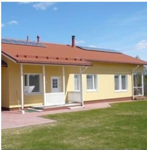
Рис. 3.8: Солнечная фотоэлектрическая установка на крыше жилого дома в г. Лаппеенранта (Финляндия).
