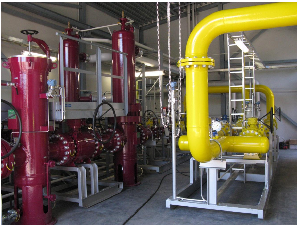
Kuva 2. Paineenvähennysaseman sisätilat.
