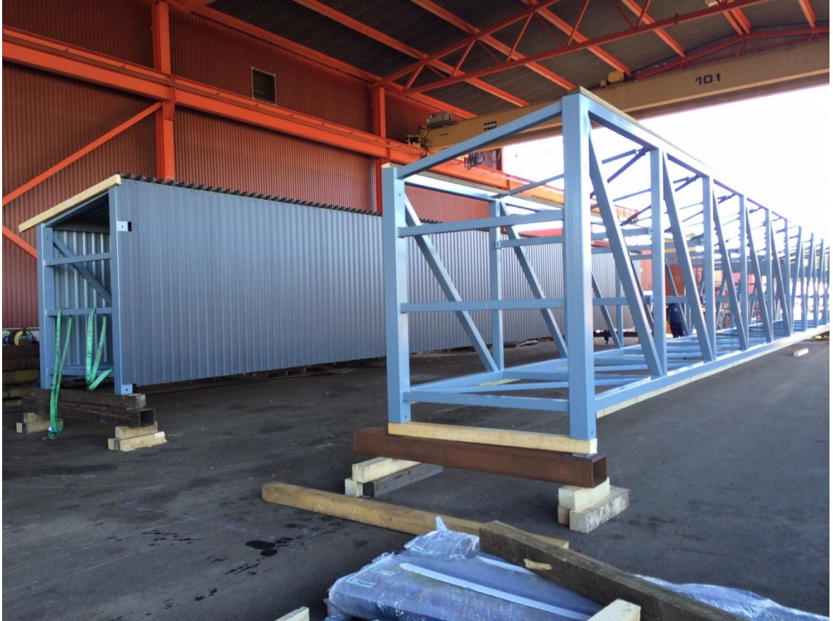
Kuva 26. Putkisillan osakoonpanot pellitettävänä.
