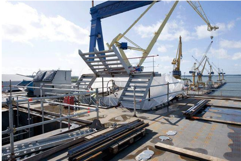
Kuva 30. TUI-varustamon risteilijän laivaportaatt asennuksessa. (Koneteknologiakeskus Turku Oy, 2014)
