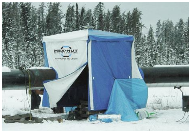
Kuva 7. Hitsausteltoa suojaamassa putkilinjan hitsausta (Industrial Machinery Digest, 2013).
