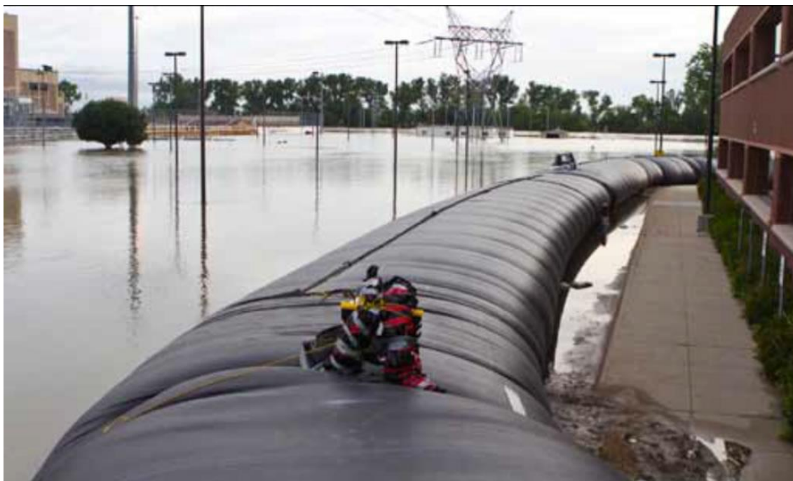
Kuva 4. Väliaikainen tulvavalli Fort Calhoun ydinvoimalaitoksella. (Nebraska Power Association, 2011)
