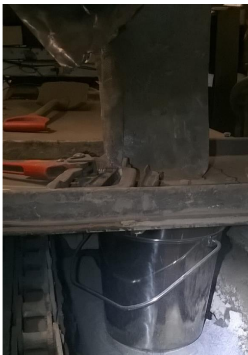
Kuva 1. Vasemmalla mittauspiste 1, jossa näytteenottoastia on asetettu konvektiotulistimelta putoavan tuhkavirran alle. Oikealla mittauspiste 2, jossa näytteenottoastia on asetettu ilmanesilämmittimeltä putoavan tuhkavirran alle. Normaalitylanteessa nämä tuhkavirrat tippuvat samalle kolakuljettimelle, jota pitkin
