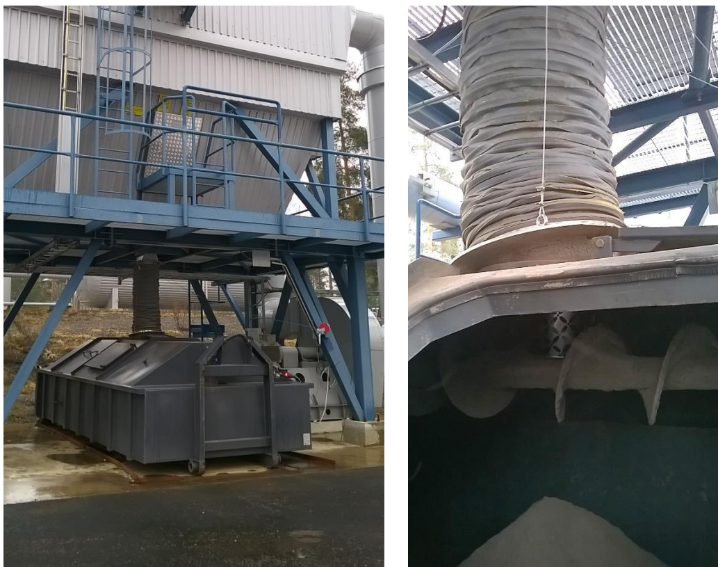
Kuva 7. Mittauspiste 2. Vasemmalla kuva lentotuhkalavasta sähkösuodattimen alla ja oikealla kuva näytteenottoastiasta putoavan tuhkavirran alla lentotuhkalavalla tuhkaruuvivin päällä. Näyte otettiin putoavasta virrasta, kuten standardissa SFS-EN 932-1 on kerrottu.
