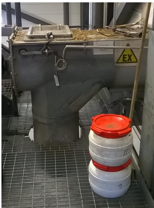
Kuva 5. Polttoainenäytteenottopiste ja polttoainenäytteenottoastiat. Polttoainenäytteet otettiin putoavasta virrasta standardin SFS-EN 932-1 mukaisesti.
