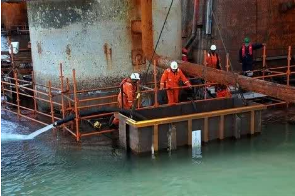
Kuva 4. Arkkupato pumpataan kuivaksi (Core-IRM, 2015).
