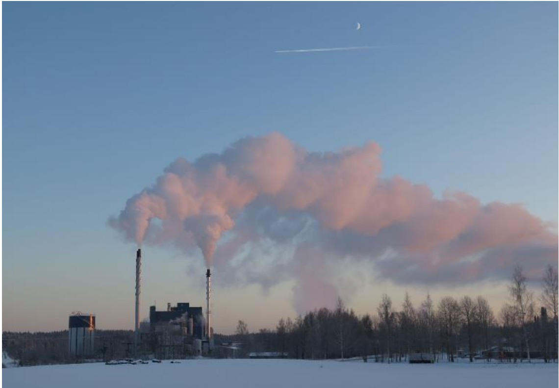
Kuva 1. Pursialan molemmat voimalaitosyksiköt käymässä täydellä teholla tammikuun 2016 kovimpien pakkasten aikana. Voimalaitoksen vasemmalla puolella näkyvä suurikokoinen säiliö on ESE:n uusi kauko-lämpöakku (ESE. 2014c, 13).
