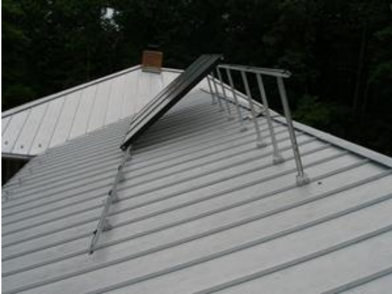
Kuva 6. Katolle asennettu teline.(Ecosmartinc, 2015)
