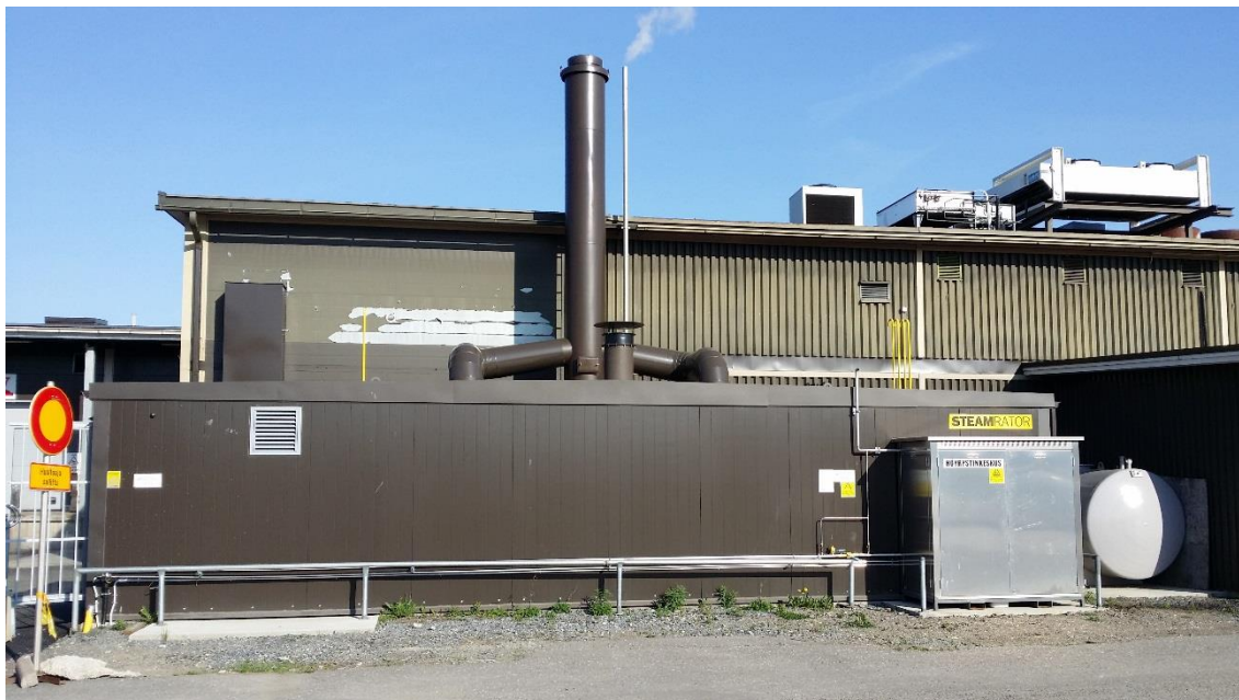
Kuva 5. SteamRator -lämpökontti Kivikylän Kotipalvaamon Huittisten tehtaalla.
