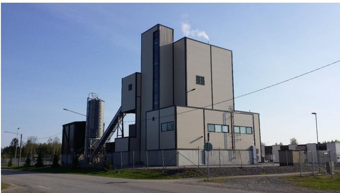
Kuva 7. Advenin lämpölaitos, joka tuottaa prosessihöyryä Saarioisten tehtaalle ja kaukolämpöä Huittisten kaukolämpöverkkoon.
