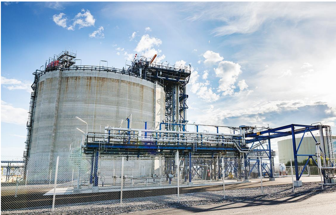
Kuva 2. Skangasin rakentama LNG-terminaali Porin Tahkoluodossa. Terminaalin kapasiteetti on 30.000 m 3 (15.000 t) ja se on yhteydessä Kaanaan teollisuusalueelle rakennettuun 12 km:n pituiseen maakaasuputkeen. (Skangas)
