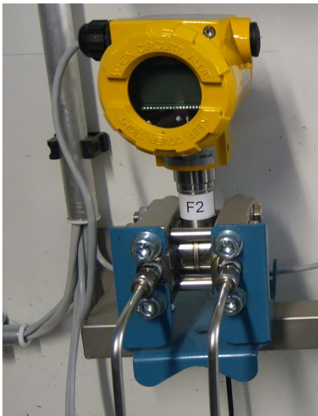
Kuva 12. Aplisensin APR2000-tyyppinen paine-erolähetin. Kuvan alaosasta tulevat impulssiinjat kytkeytyvät lähettimen prosessilaippoihin.
