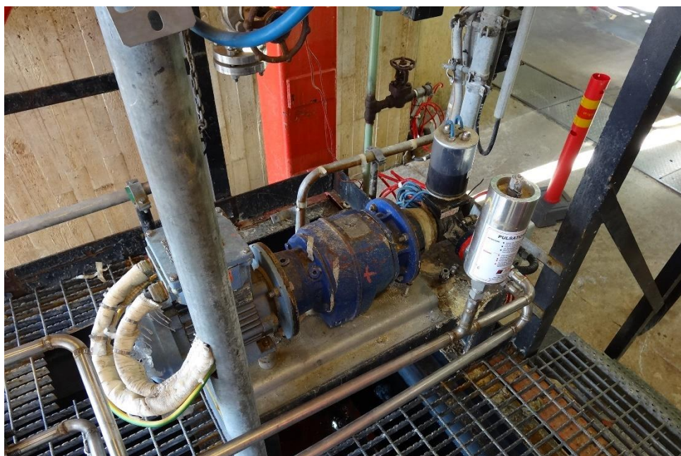
Kuva 26. Pumppu GA-1BS kuvattuna oikeassa toimintaympäristössä ilman eristeitä (Borealis 2014c).
