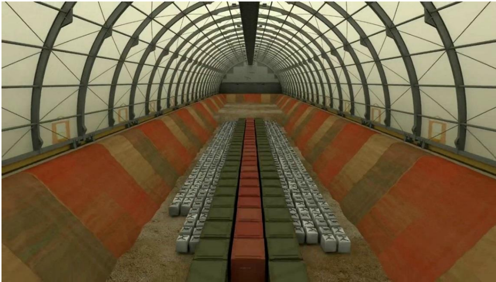
Kuva 6. Täyttövaiheessa oleva loppusijoituskammio CIRES-laitoksella Morvillersissa, Ranskassa. (ANDRA)
