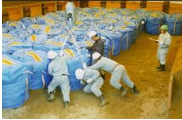
Kuva 13. Jätepussien asentamista loppusijoituskammioon, Tokai, Japani (JAEA, 2015)
