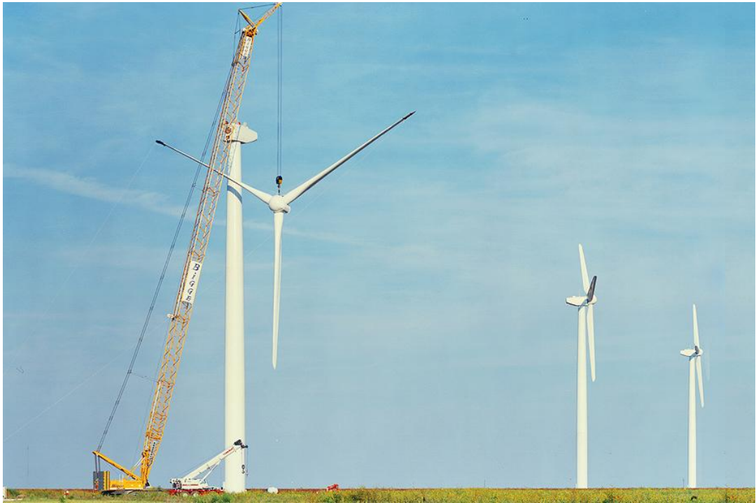
Kuva 5. Komposiitista valmistettua kaapelia käyttävä nosturi nostamassa tuulivoimalan lapoja (Carbo-Link).
