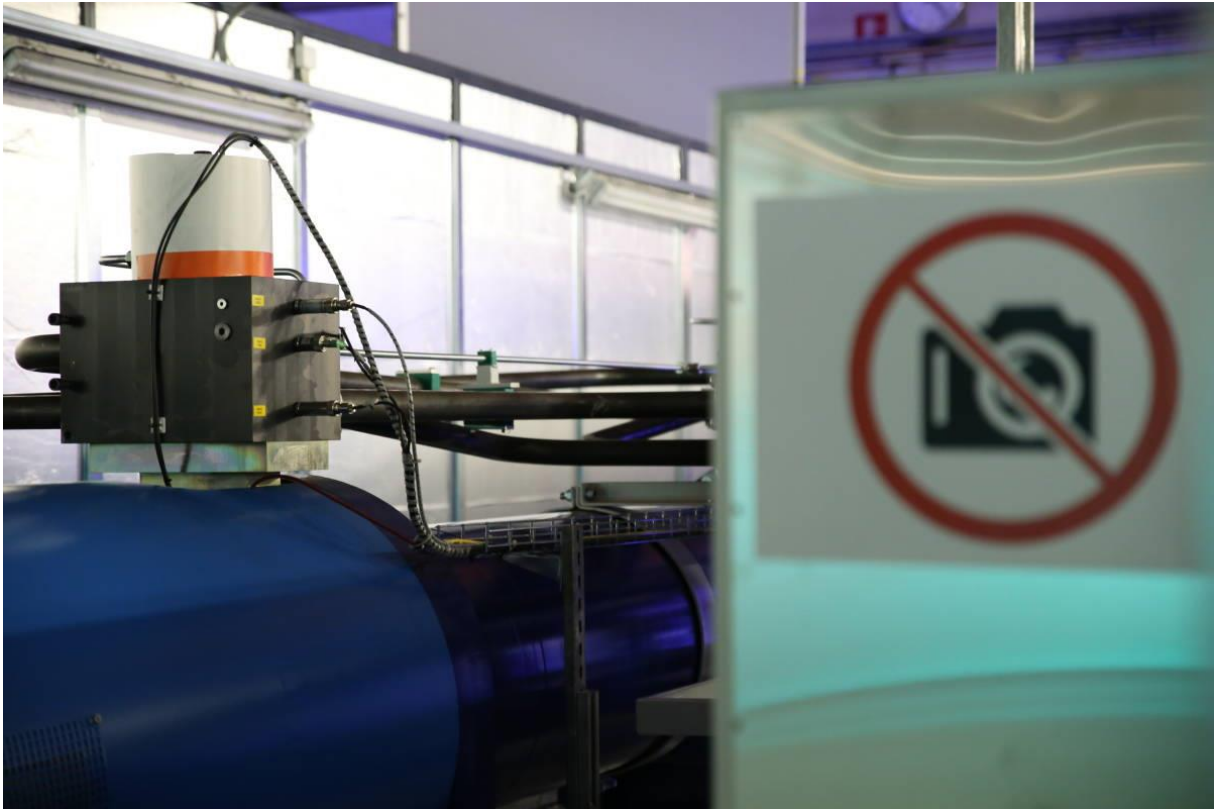
Kuva 9. Vilaus Järvenpään tehontuottojärjestelmän testilaitoksesta.
