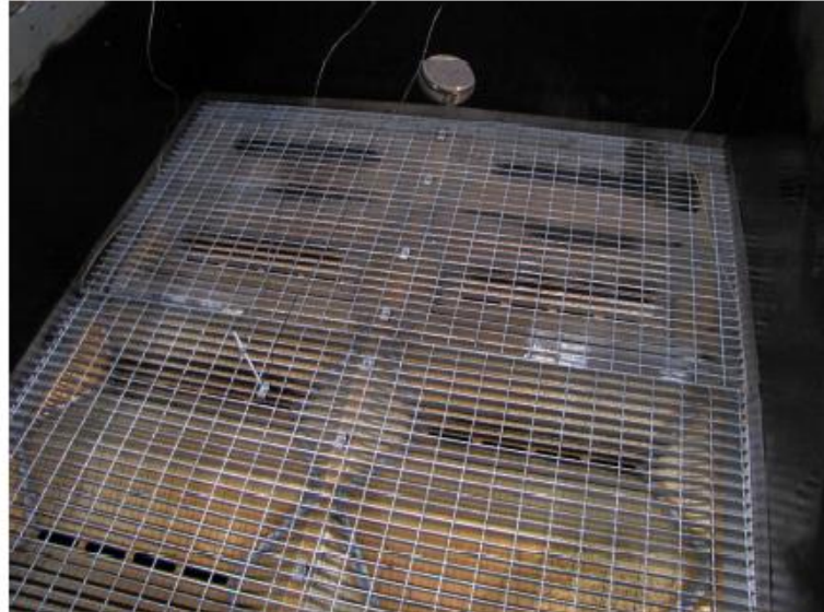
Kuva 3. Liekkiloukku - palonsuojakrakenne asennettuna öljykammion päälle.
