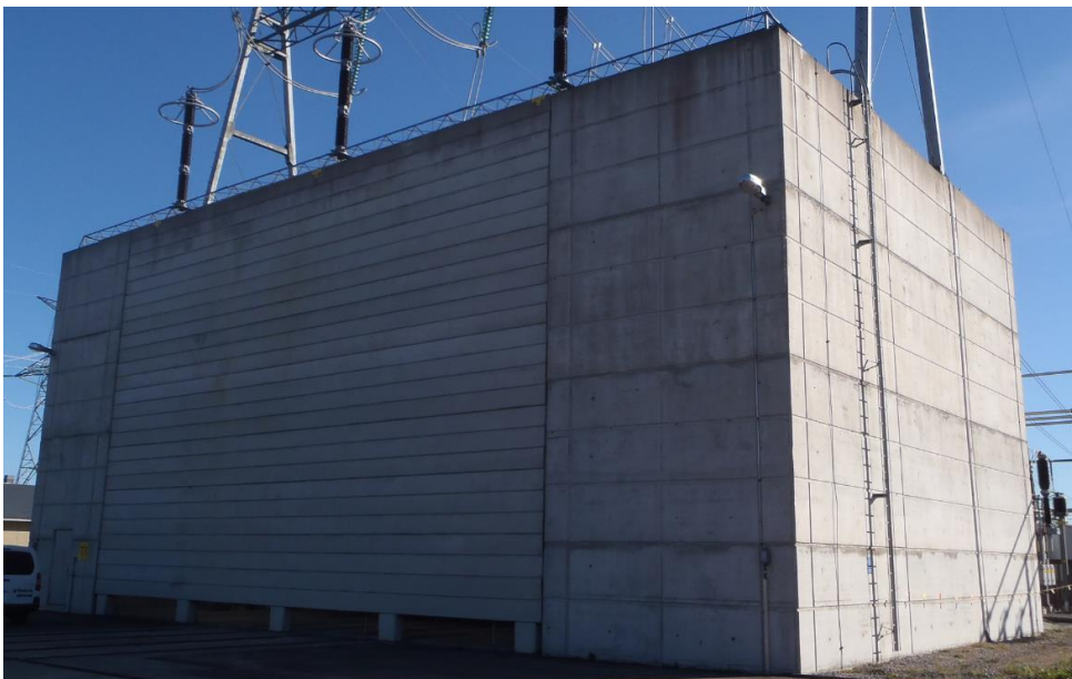
Kuva 4. Suurjännitemuuntajan bunkkeri.
