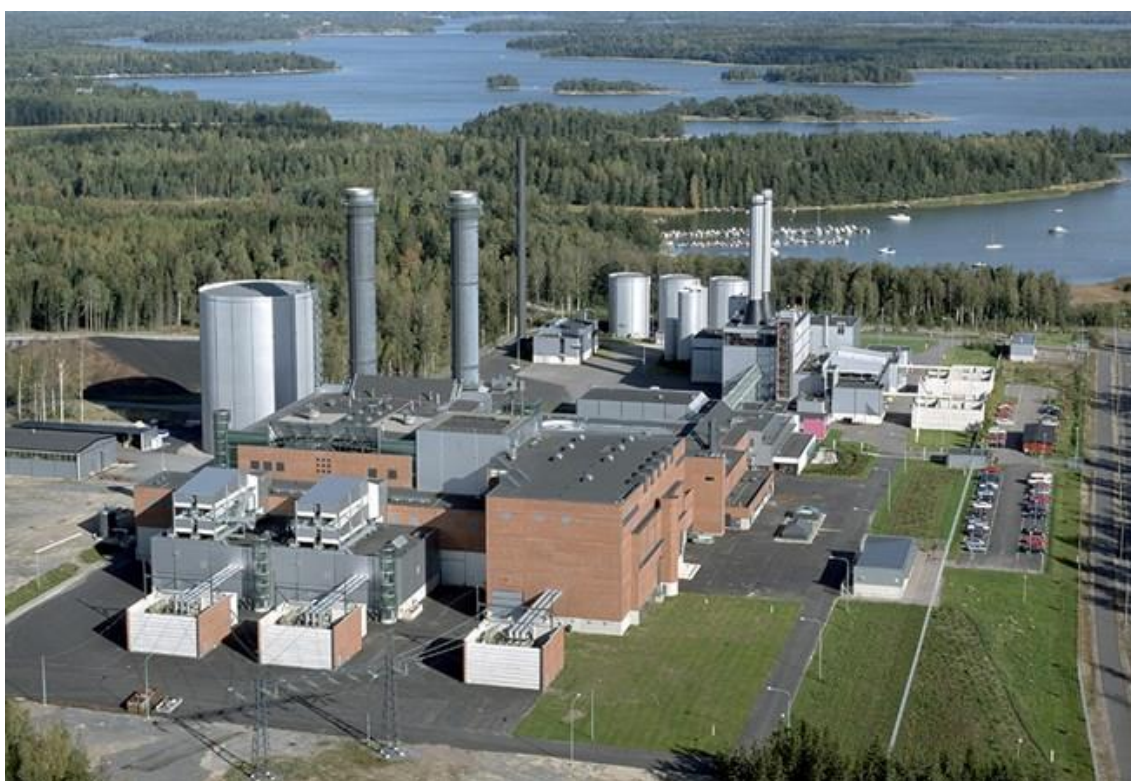
Kuva 8 Helsingin energian Vuosaaren voimalaitos. Kuvassa savupiipuista vasemmalle näkyvä harmaa säiliö on kaukolämpövesiakku, jolla tuotantoa voidaan tarvittaessa tasata. (Helen, 2016)
