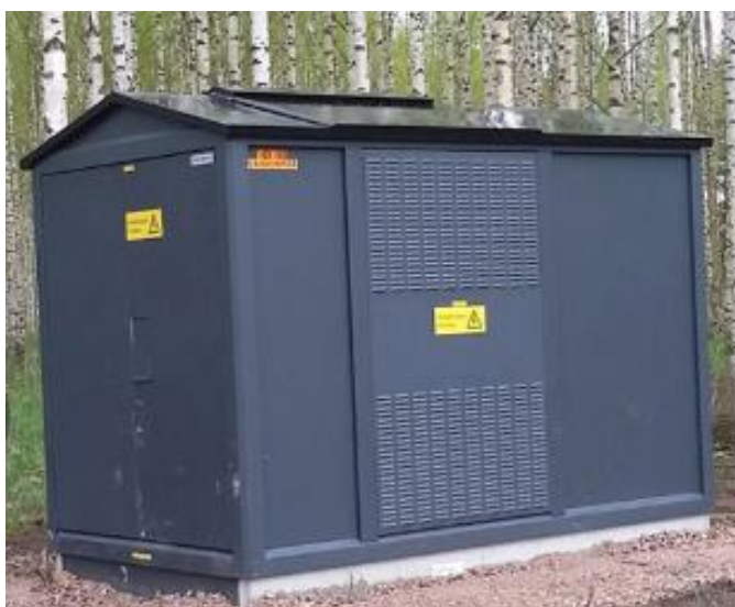
Kuva 2. Virolaisen Harju Elekterin valmistama puistomuuntamo. (Elenia)
