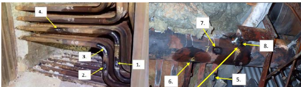
Kuva 7. II-tulistimen ja kokoojatukin jäljennetarkastuspisteet. (Puttonen et al. 2019, 5)
