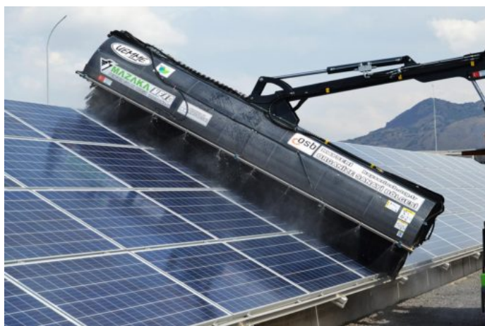
Kuva 20. Likaantuneiden aurinkopaneelien puhdistus harjapesurilla (Groundwork Experts, 2019)
