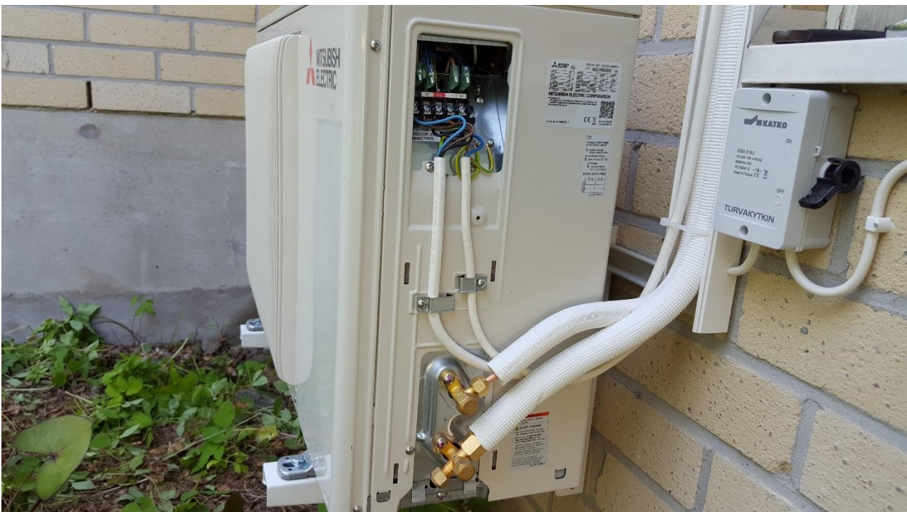
Kuva 4. Ulkoyksikkö putket ja sähköjohdot asennettuna.
