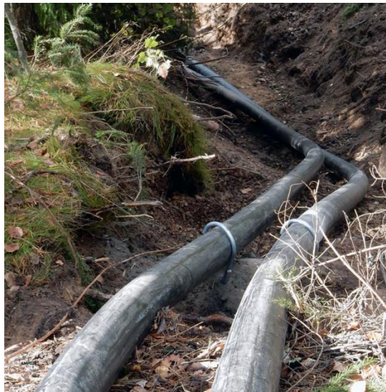
Kuva 3.5 Maakaapelin suojaus SRE-putkella. (Onninen, 2017)
