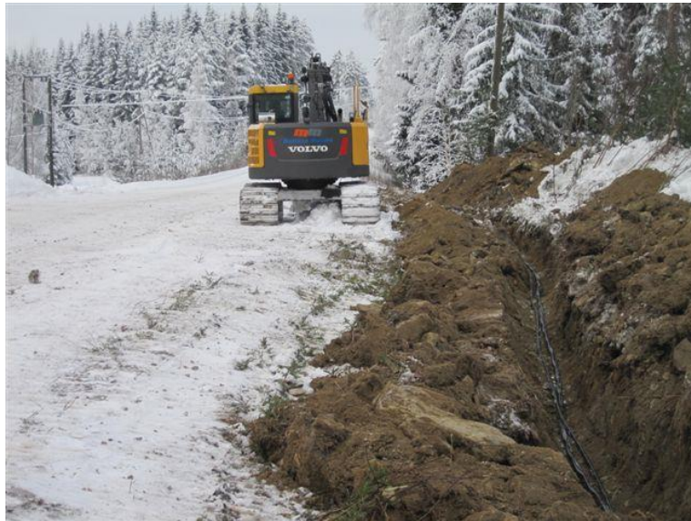
Kuva 3.2 Maakaapelin kaivuujoa kaapelinvedon jälkeen. (ELY-keskus, 2018)
