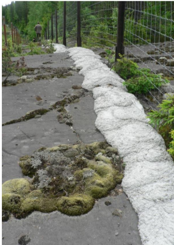
Kuva 3.4 Maakaapelin suojaaminen päälle valetulla betonilla. (Hämäläinen ja Teriö, 2011)
