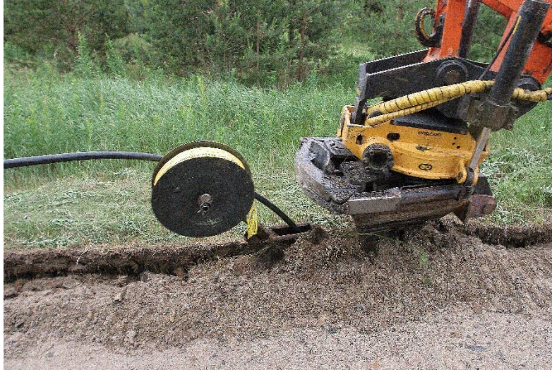
Kuva 3.3 Pienjännitemaakaapelin aeraus käytännössä.
