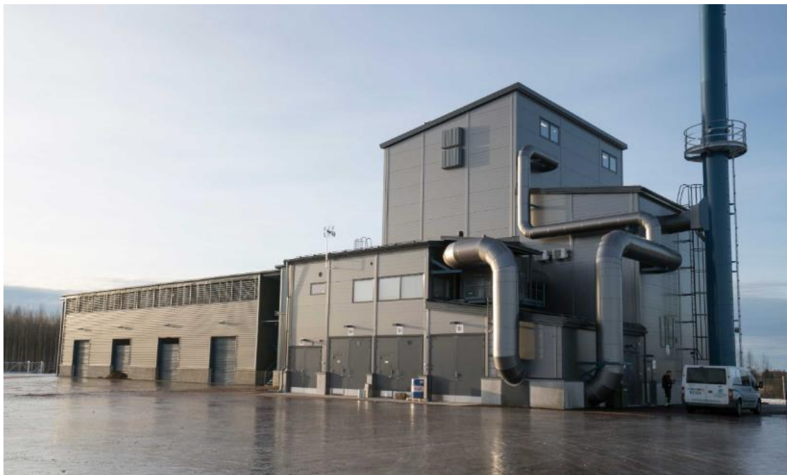
Kuva 10. Kauhavan Kaukolämmön 10 MW kiinteän polttoaineen laitos
