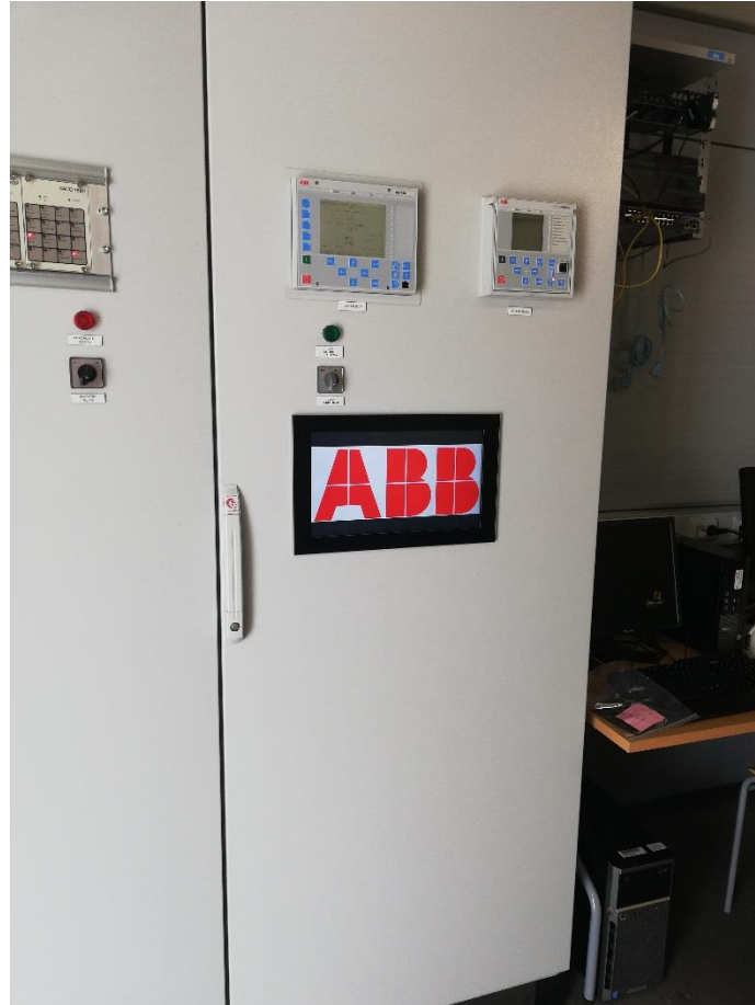
Kuva 4.1. RPU-laitteen asennuksen toteutus päämuuntajan suojakaapin ovenssa.
