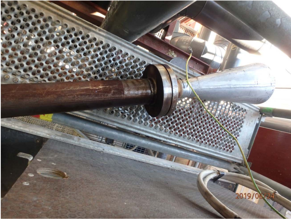
Kuva 3 Ejektorin höyrysuutin
