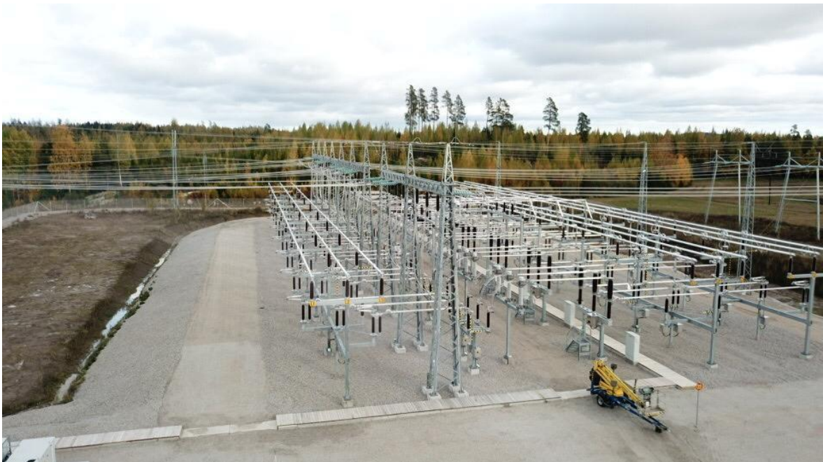
Kuva 1.1 Orimattilan sähköasema lokakuussa 2019. TMV Servicen valmistunut työmaa, missä työn kirjoittaja oli myös mukana. (Fingrid)
