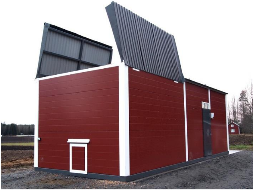
Kuva 1. Siirrettävä lämpökontti, jossa hakevaraston katto on avattu. (Biofire Oy 2020).
