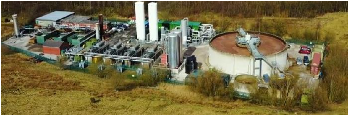
Kuva 5. Ensimmäinen täyden mittakaavan LAES-laitos Pilsworthin kaatopaikan kaasuturbiinilaitoksen yhteydessä (Highview Power. 2018)
