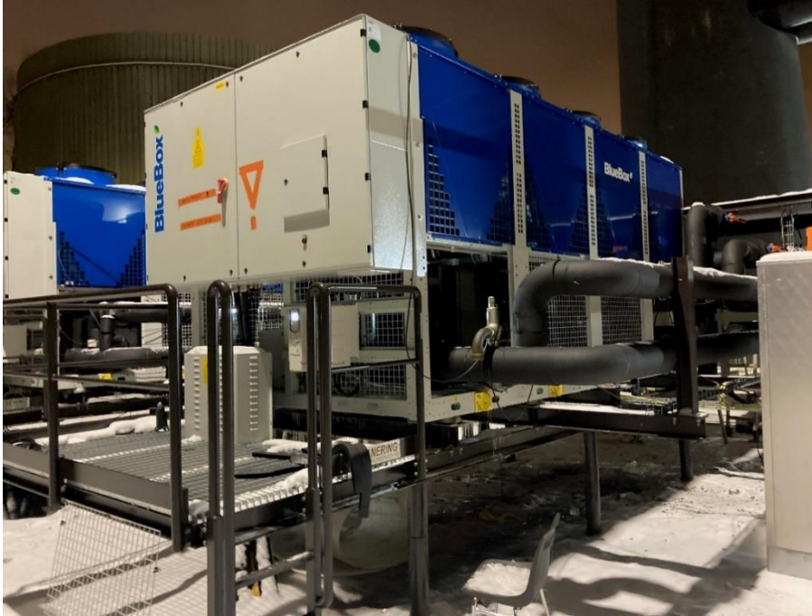
Kuva 19. Lämpöpumput Otaniemen laitosalueella
