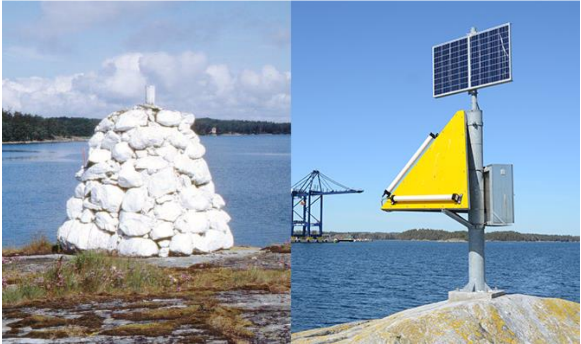
Kuva 3. Vasemmalla Kyrkogårdsön kummeli Kirkkonummen edustalla ja oikealla aurinkopaneeleilla ladattava akkukäyttöinen levykummeli Norvikin sataman edustalla. (Nyman 2009, 7), (Bergström 2020)
